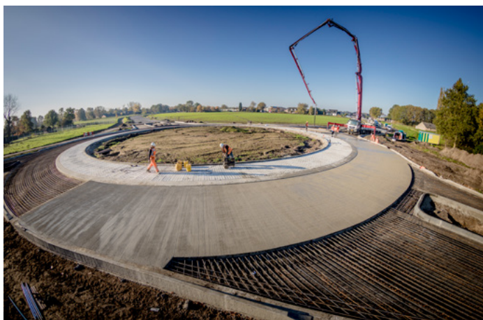
Aanleg rotonde Molenstraat
