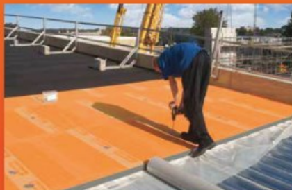
plat dak isolatie
