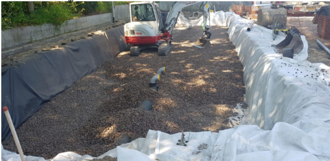
Afbeelding 2: voorbeeld van een lava-pakket welke als berging gaat dienen onder de wegfundering.
